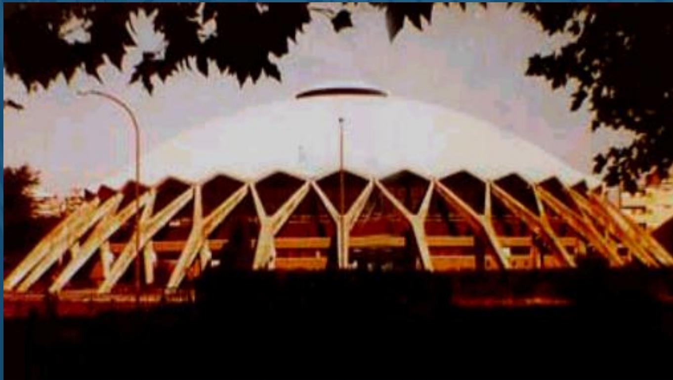
球形穹顶屋盖、Y形支撑、天桥“腰带”
