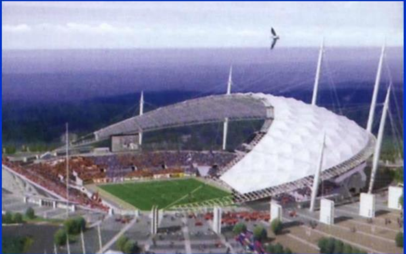
韩国济州西归浦世界杯体育场 (支承骨架：钢管桁架 + 桅杆 + 索)
