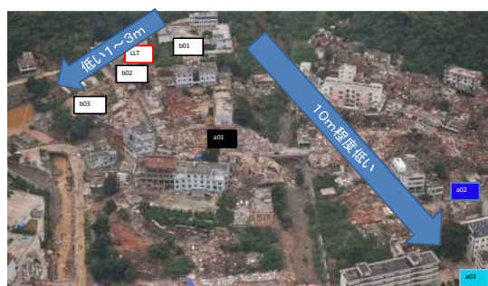
龍頭山の建物被害状況及び微動観測
